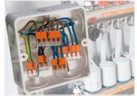
İnce telli iletkenlerin bağlantı kutularında kablolanması
